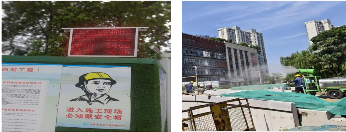
图 4-1 苫盖及洒水降尘
